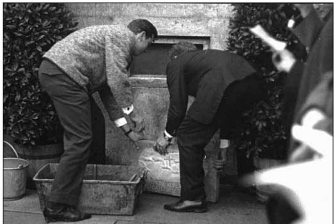
Der Grundstein wird geschlossen.
